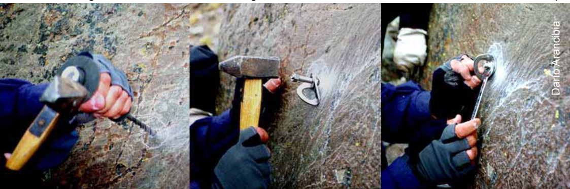
Instalación de un bolt con buril de mano paso a paso.
